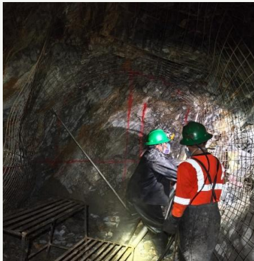
SOSTENIMIENTO CON MALLA
