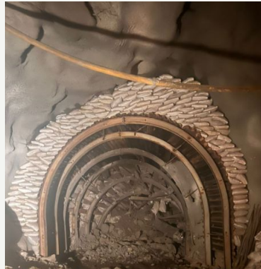
SOSTENIMIENTO CON CUADRO DE MADERA
