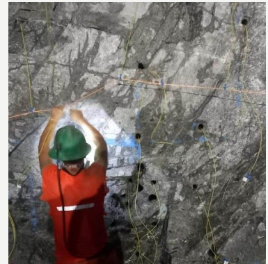
SOSTENIMIENTO CON PERNOS Y MALLA
