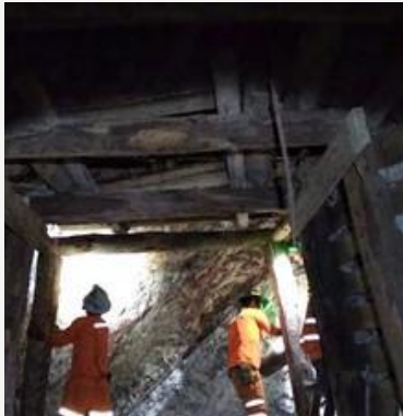
SOSTENIMIENTO DE AVANCE 3.5 X 3.5 M
